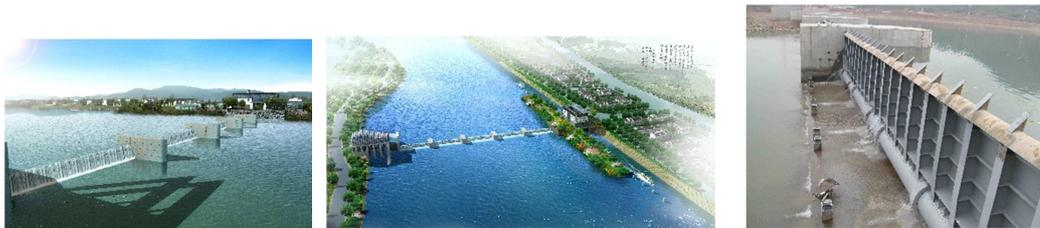
照片 1.1 典型底轴驱动式翻板闸门工程效果图
