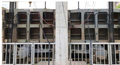
照片 1-2 飞力一体化泵闸装置近景图
