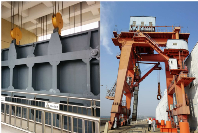
图 3 产品测试的工地现场
