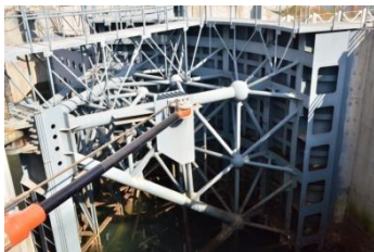
(c) 奉化市象山港管桁式三角闸门
